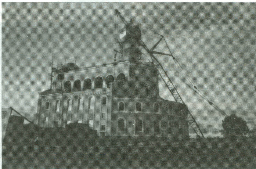
Nowo budowany kościół w Krasnojarsku
