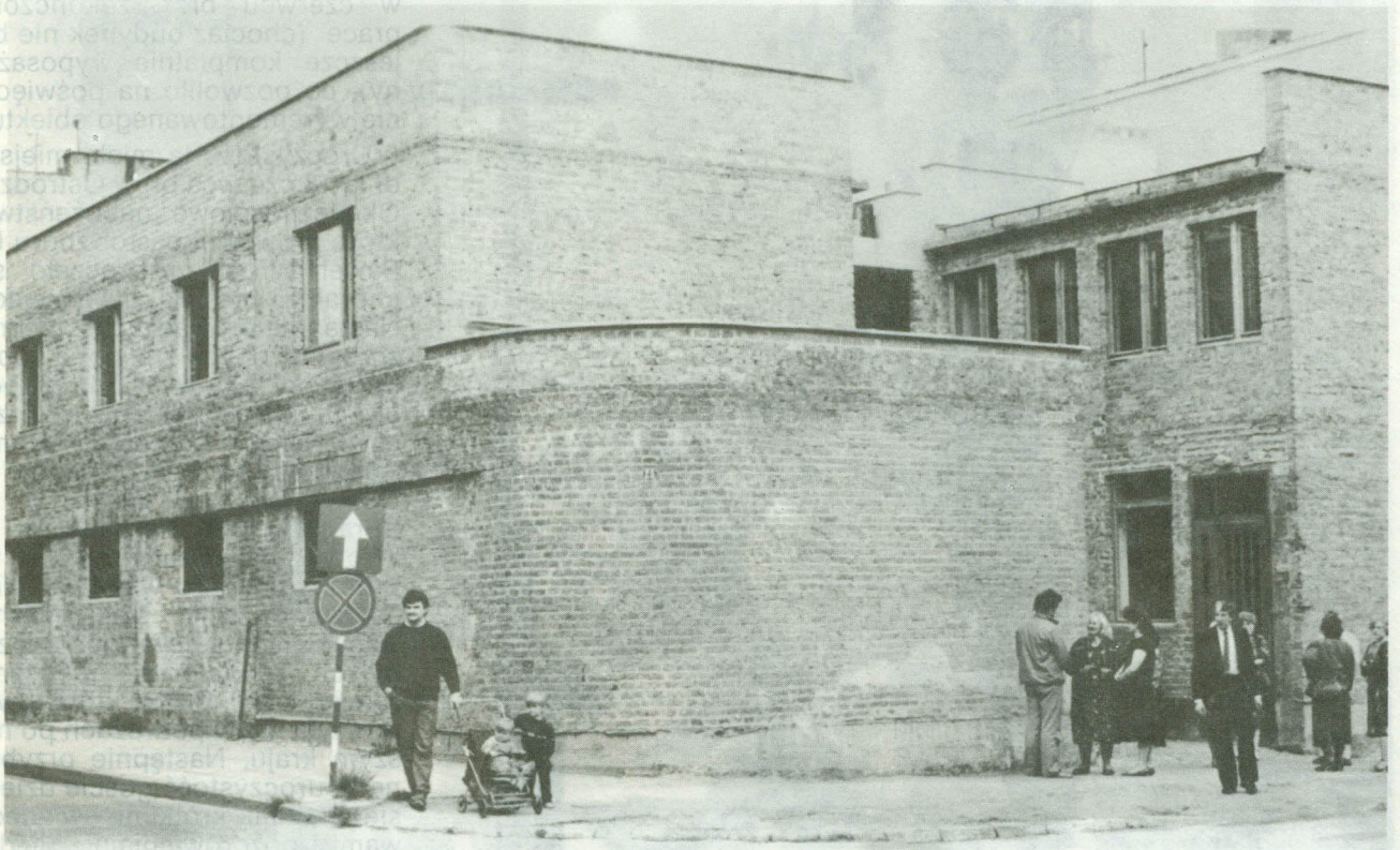
Ta sama kaplica, po generalnym remoncie
