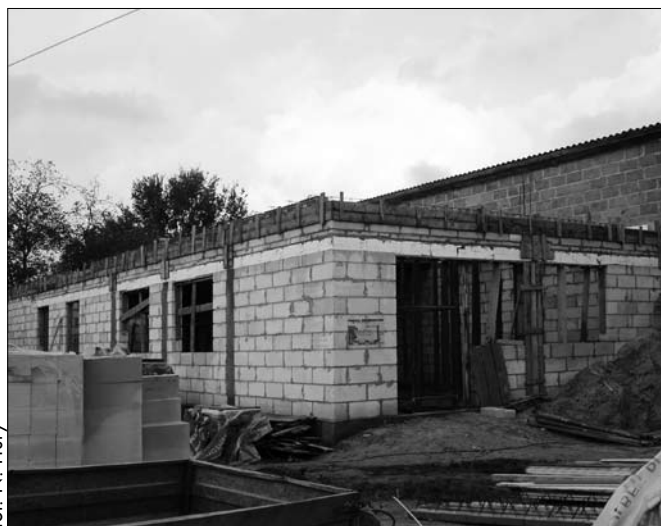
Zbór siemiatycki rozpoczął budowę Domu Katechetycznego na swojej posesji przy ul. Drohiczyńskiej
